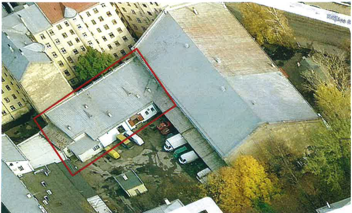
2. attēls. Nolikta Rīgā, Brīvības ielā 188, k-1, lit.003 (novietne ; attēls no Google maps).
