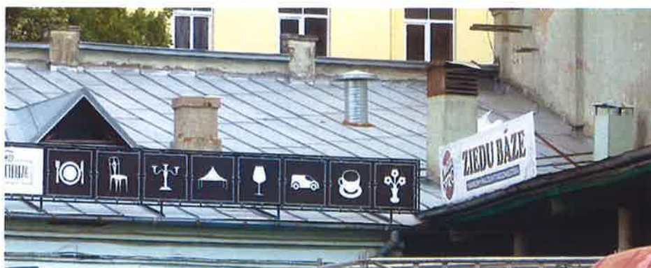
7., 8., 9. attēls. Noliktavas Rīgā, Brīvības ielā 188, k-1, lit.003 DA fasādes un jumta ZA daļas fragments.
