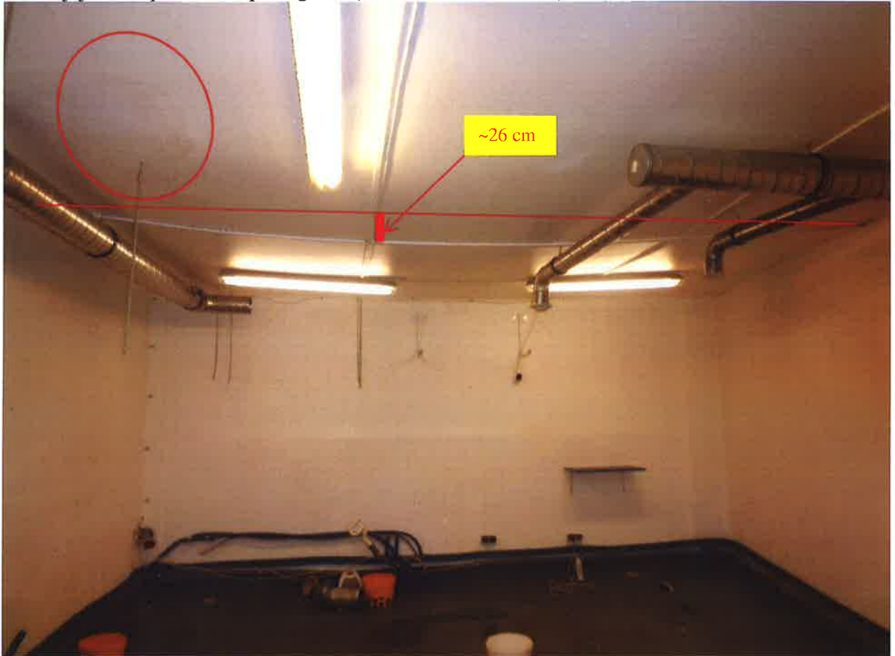
13. attēls. Noliktavas Rīgā, Brīvības ielā 188, k-1, lit.003 telpa Nr. 12 ar griestu apšuvuma izliekumu ~26 cm un mitrinājumu. ○
