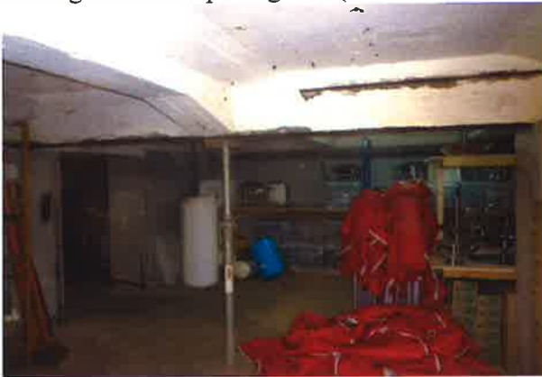
24. attēls. Pasijas stiprinājuma vieta Nr. 1 1. laidumā no durvīm. 25. attēls. Pārējos laidumos pasijai pagaidām nav stiprinājumu.
