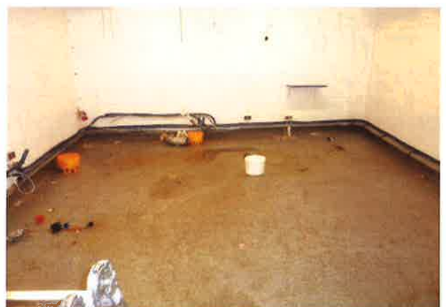
15. attēls. Grīda telpā Nr. 12 pēc iekārtu demontāžas.
